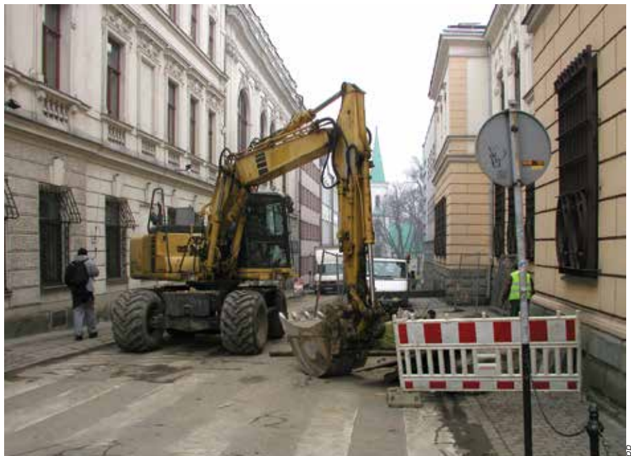
W śródmieściu trwają uciążliwe dla kierowców prace, lecz po zakończeniu inwestycji Cieszyn będzie miał nowoczesną kanalizację i lepsze drogi.
